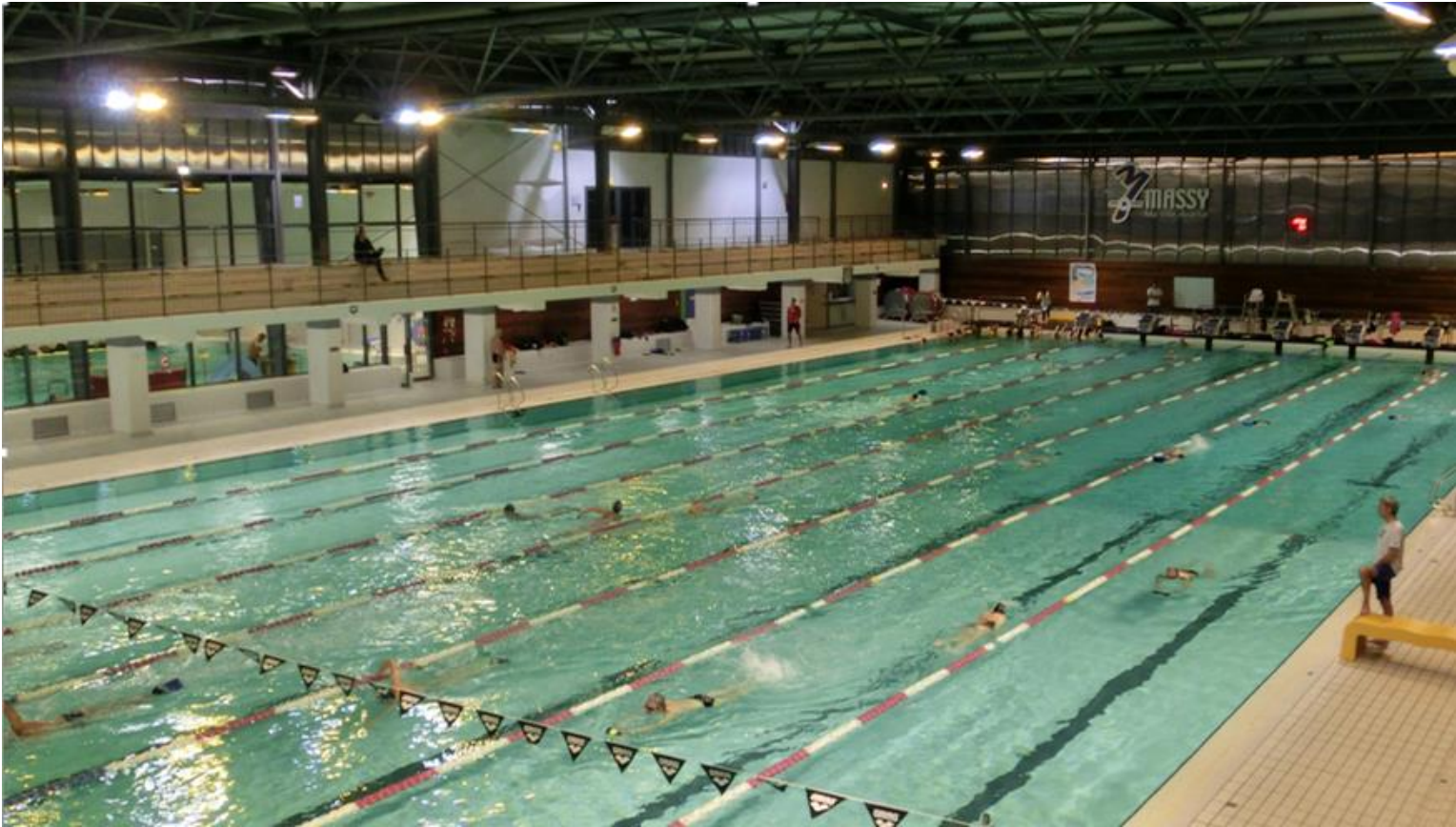
Bassin de 50m
